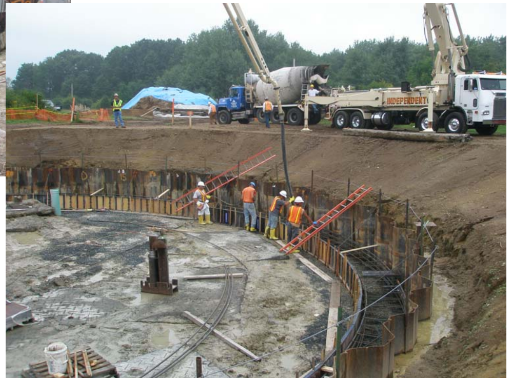
Beginning Stages of Concrete Pour
